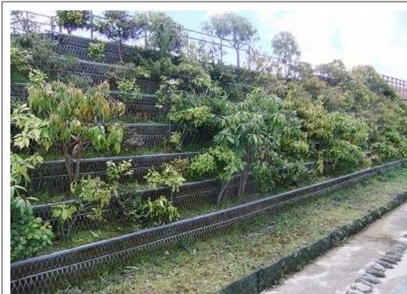
歩道橋の土台はダブルウォール構造(DW) 小段には平場を設け、低木を植樹して15年経過。
