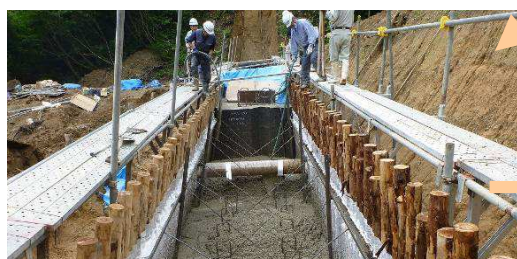
縦支柱材、横梁材設置
