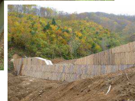
組立て→コンクリート打設→組立て …の繰り返し、完成
