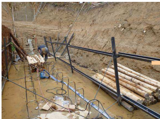
縦支柱材、横梁材設置
