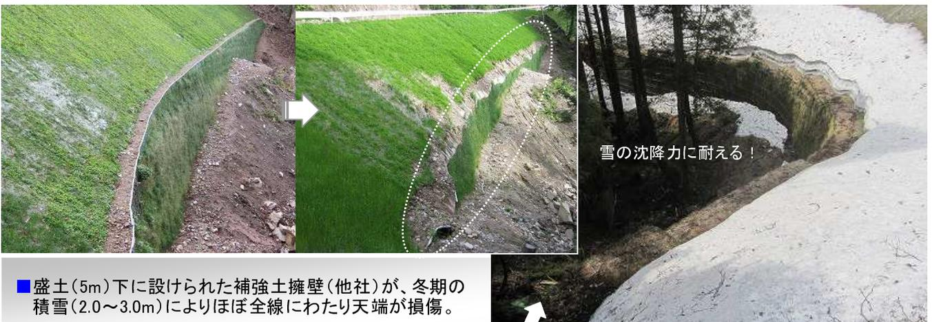
■盛土(5m)下に設けられた補強土擁壁(他社)が、冬期の積雪(2.0～3.0m)によりほぼ全線にわたり天端が損傷。
