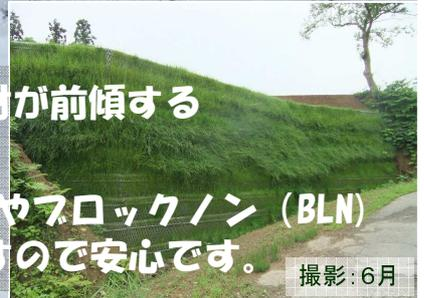
■この現場では、近隣で雪害対策を施した当社の補強土擁壁にはどれも変状がみられなかったという実績が評価され、共生の補強土擁壁(TDW)が採用されています。(※上記現場の設計積雪深：4.0m～4.5m)
